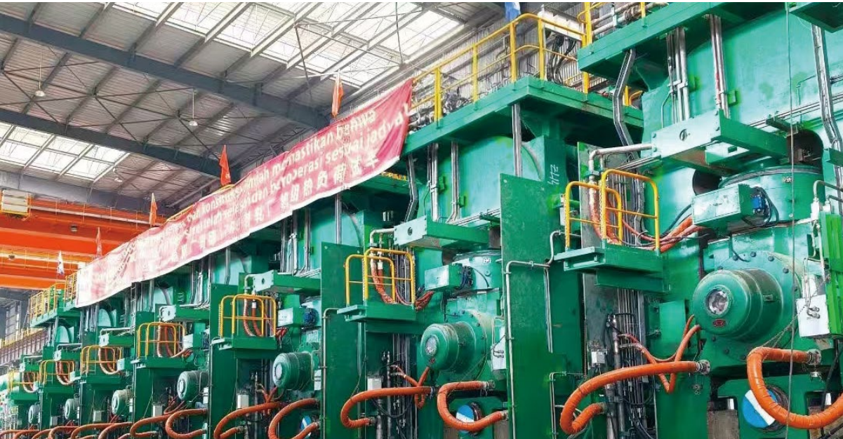
1780 毫米热连轧项目一次性全线热负荷试车成功
